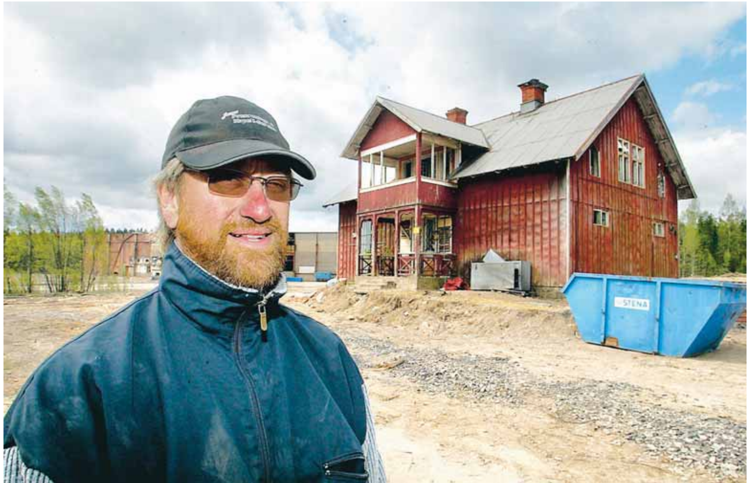
Janne Johansson framför Kilsta gård som under gårdagen började rivas.
